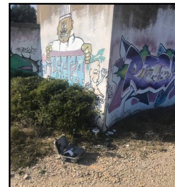
Château d'eau de Montaud
